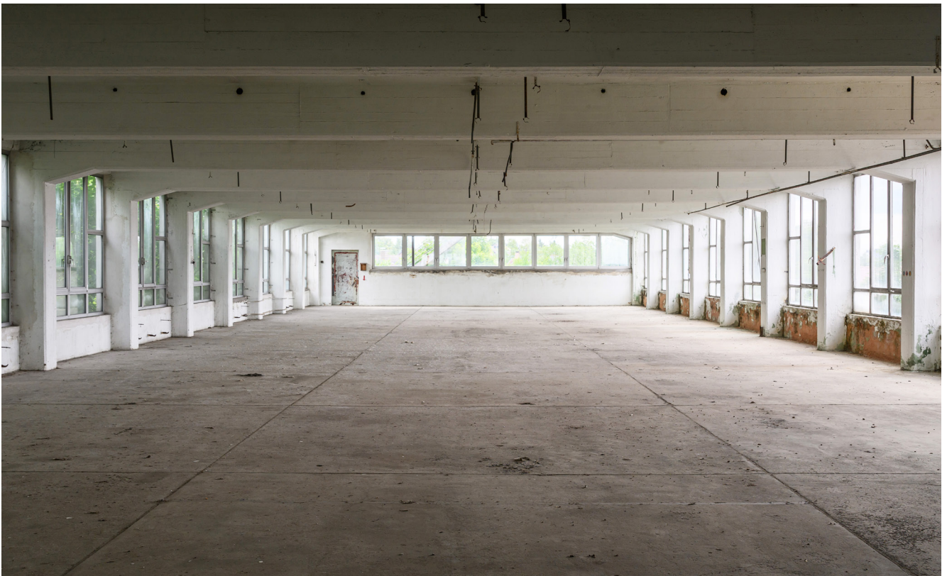
Innenansicht der ehemaligen Werkhalle
